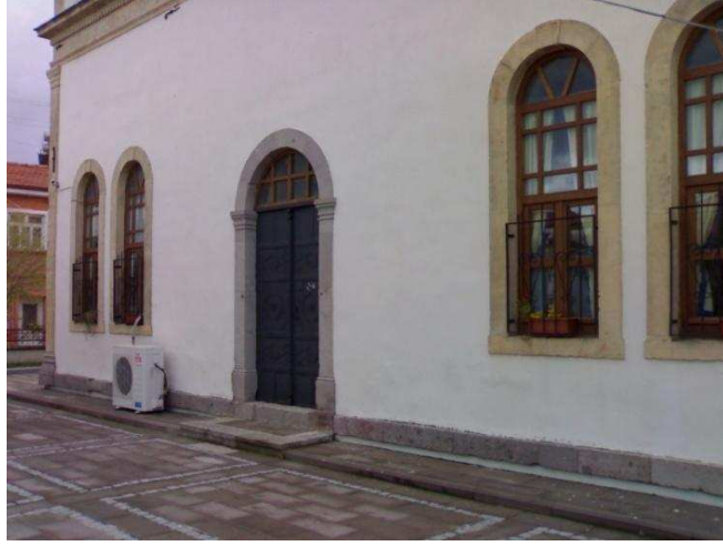
Hacı Ahmet Camii, doğu cephesi
