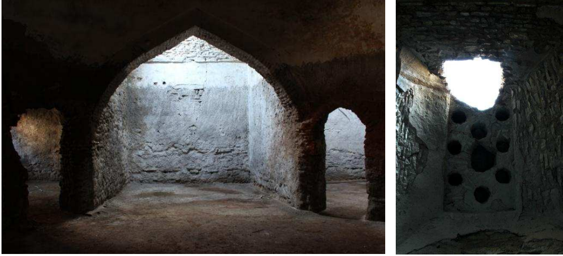
Sıcaklık merkezinden eyvan görünümü; Eyvan üzerini örten tekne tonoz
