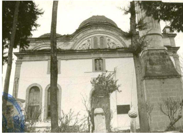
Hacı Ahmet Camii, kuzeyden
