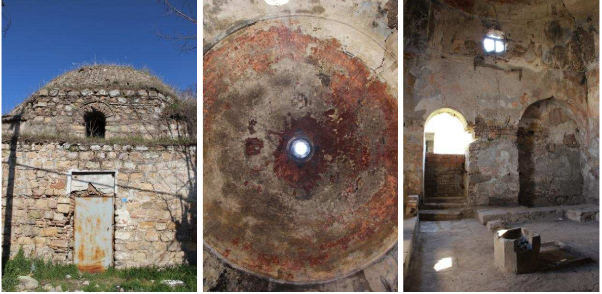
Soyunmalığın Kavakdibi Caddesi'ne açılan ana girişi; Soyunmalık kubbesi ve aydınlatma feneri; Hamamın yan girişi, havluları kurutmak için kullanılan niş ve ortada süs havuzu
