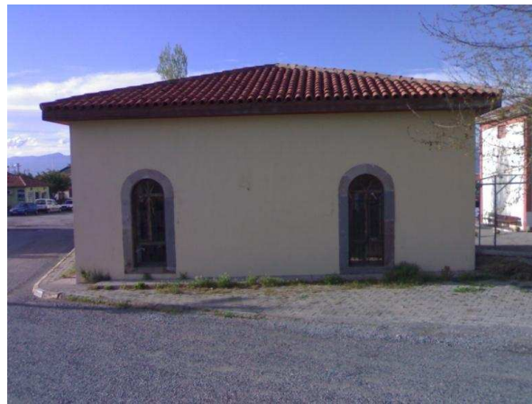
Eski İskele Camii, giriş cephesi ve arka cephesi
