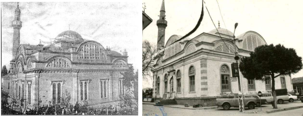
Koca Camii, 1944 öncesi 38 ; Koca Camii, 1985
