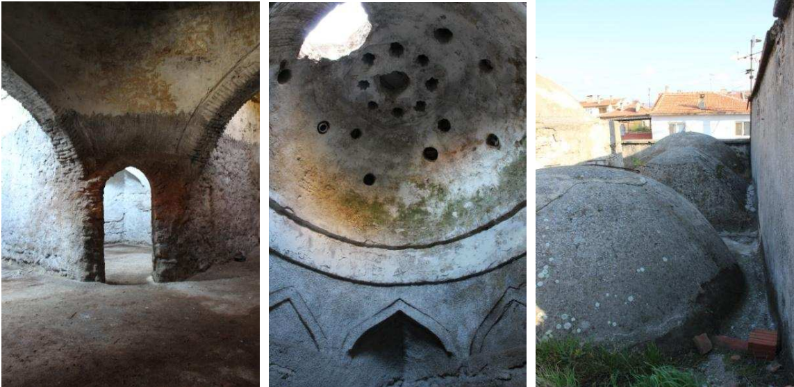
Kubbe kasnağındaki basit pandantif üzerine açılan giriş yoluyla halvet; Halvet kubbesi içten; Halvet kubbeleri ve eyvan tonozu dışarıdan
