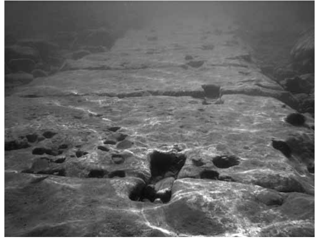
Resim 15: Limana ait bloklar ve kenet yuvaları
